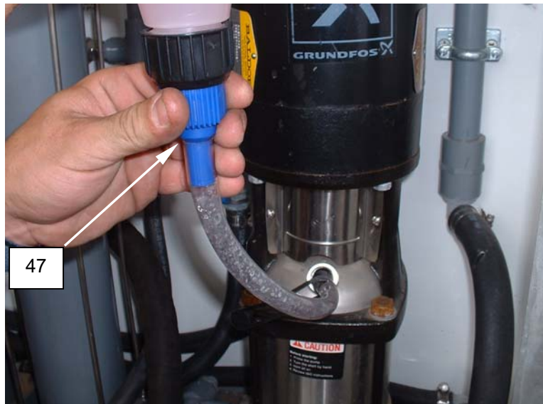
Figure 26. Add Antifreeze - Pump P-4.
